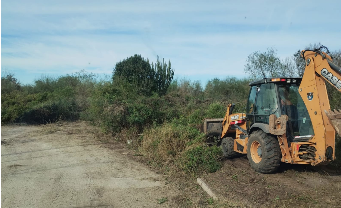
Figura 161 – Trabajos de Limpieza
