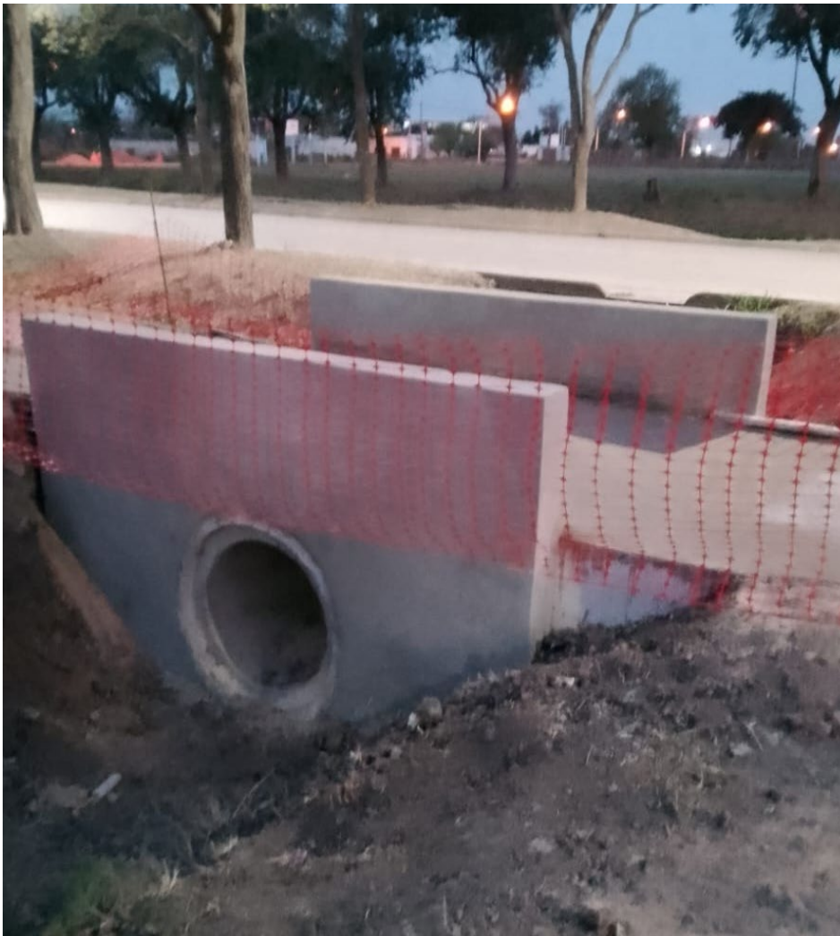
Figura 152 – Nuevo puente peatonal
