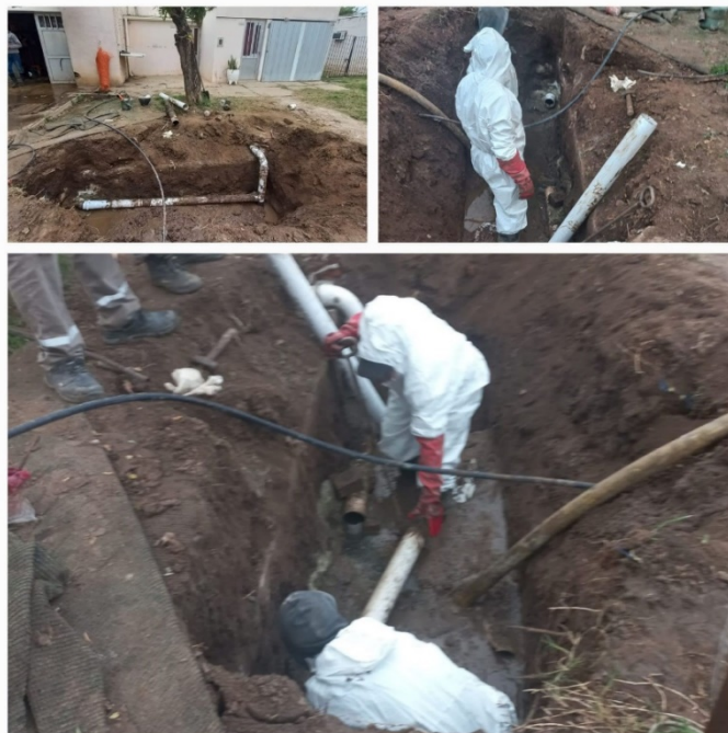
Figuras 56, 57 y 58 – reparaciones calle Lainez
