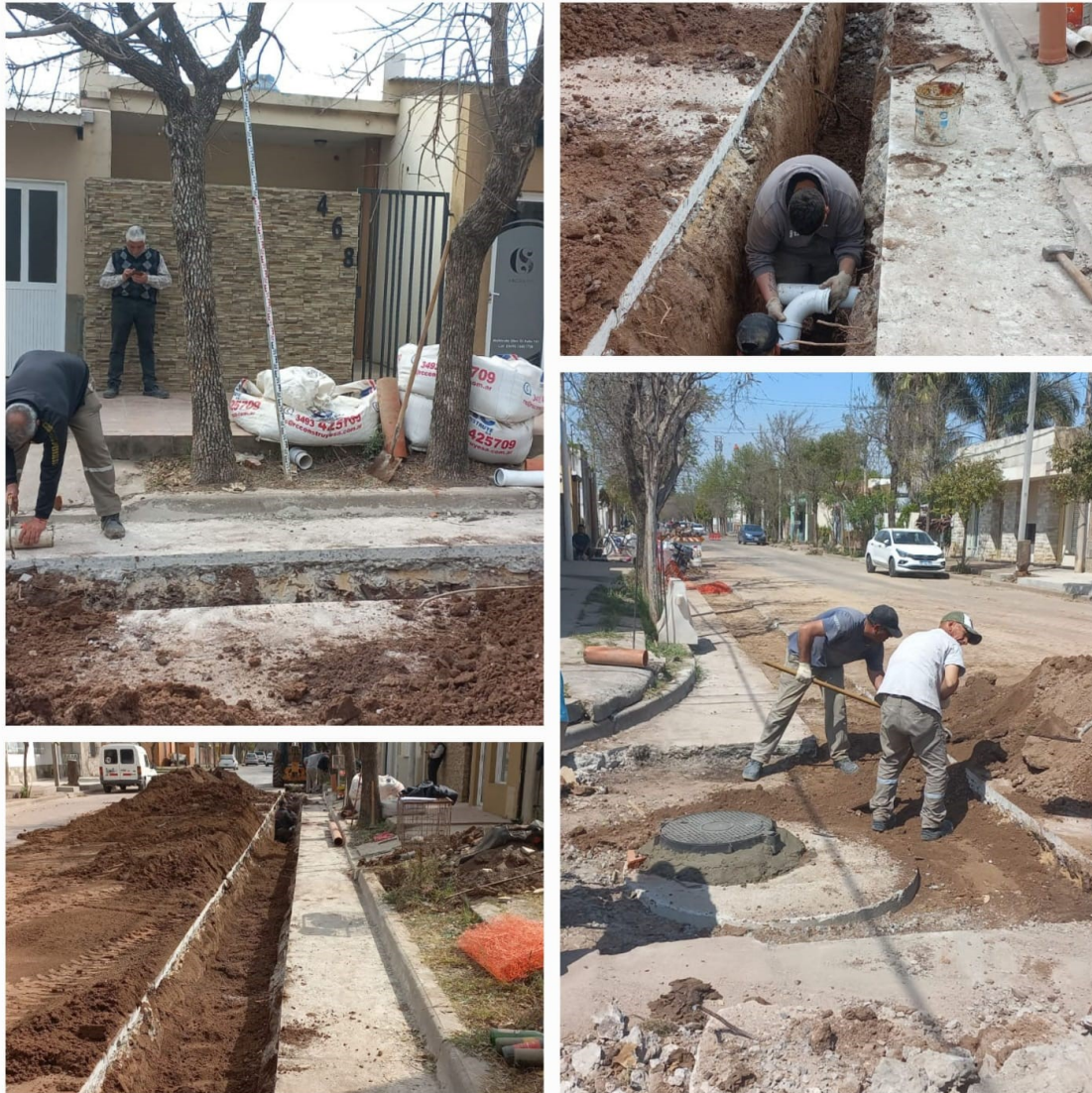
Figuras 47, 48, 49 y 50 – Trabajos en calle Alberdi.
