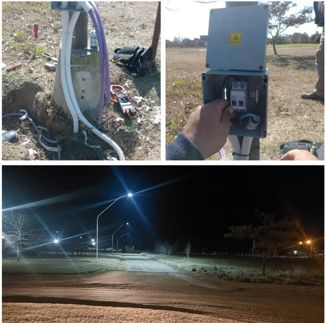
Figuras 116, 117 y 118 – Cableado subterráneo
