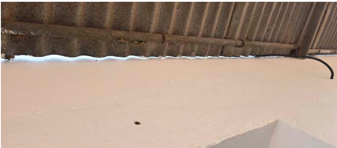
Figuras 8 y 9 – Encuentro entre chapa de cubierta y muros laterales
