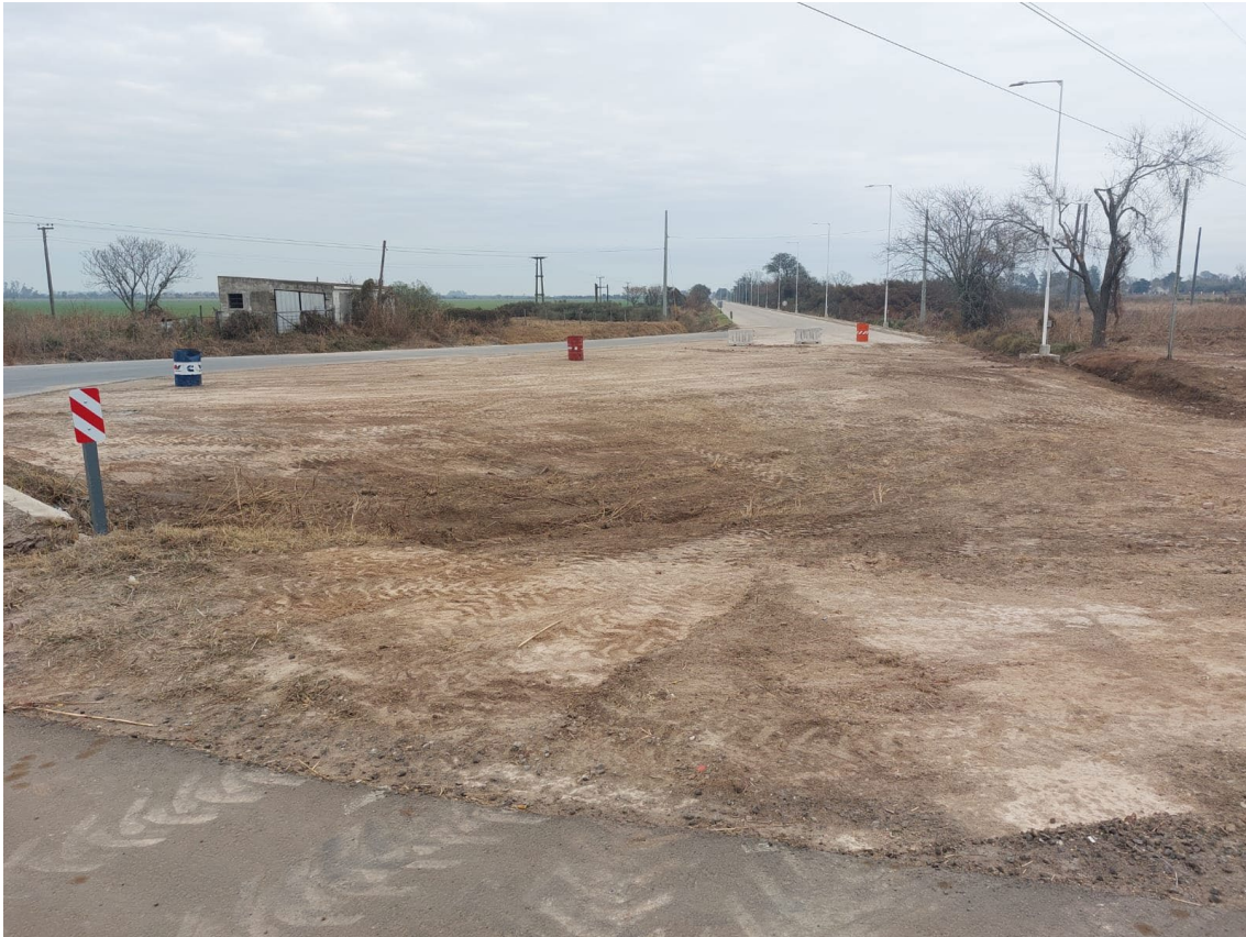
Figura 154 – Camino seguro y RN 34 posterior a limpieza
