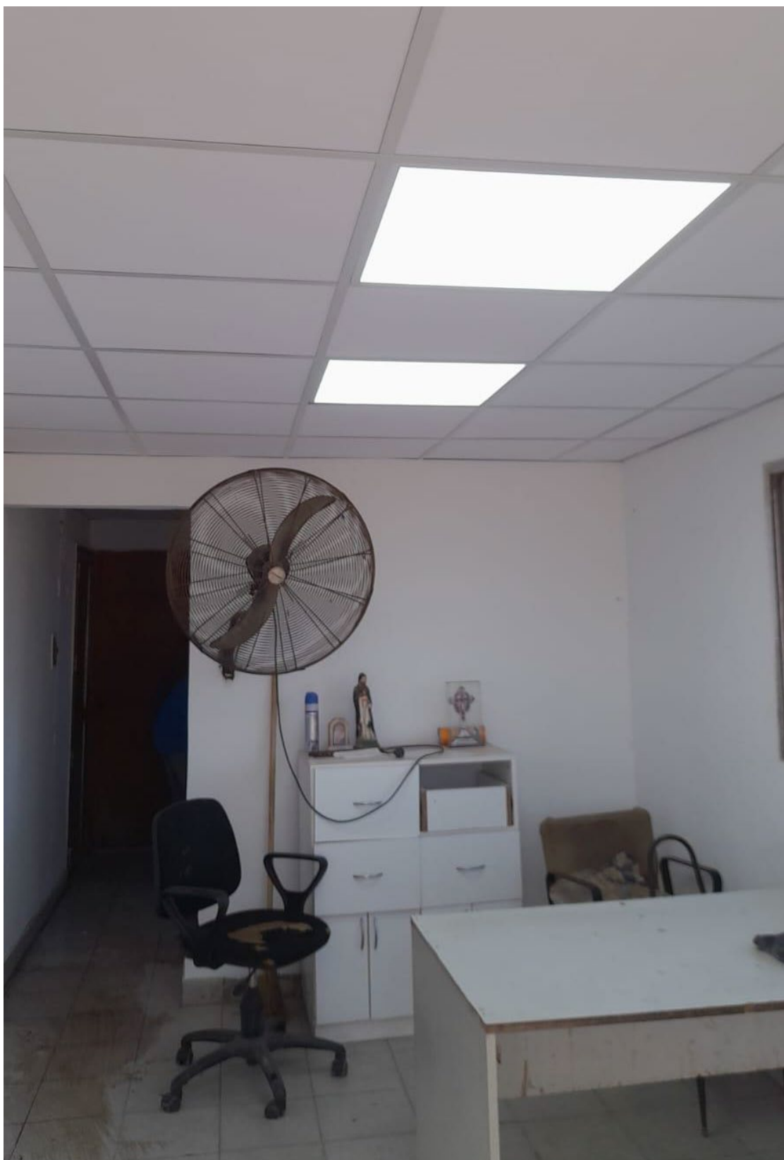
Figuras 23 – Oficina con nuevo cielorraso
