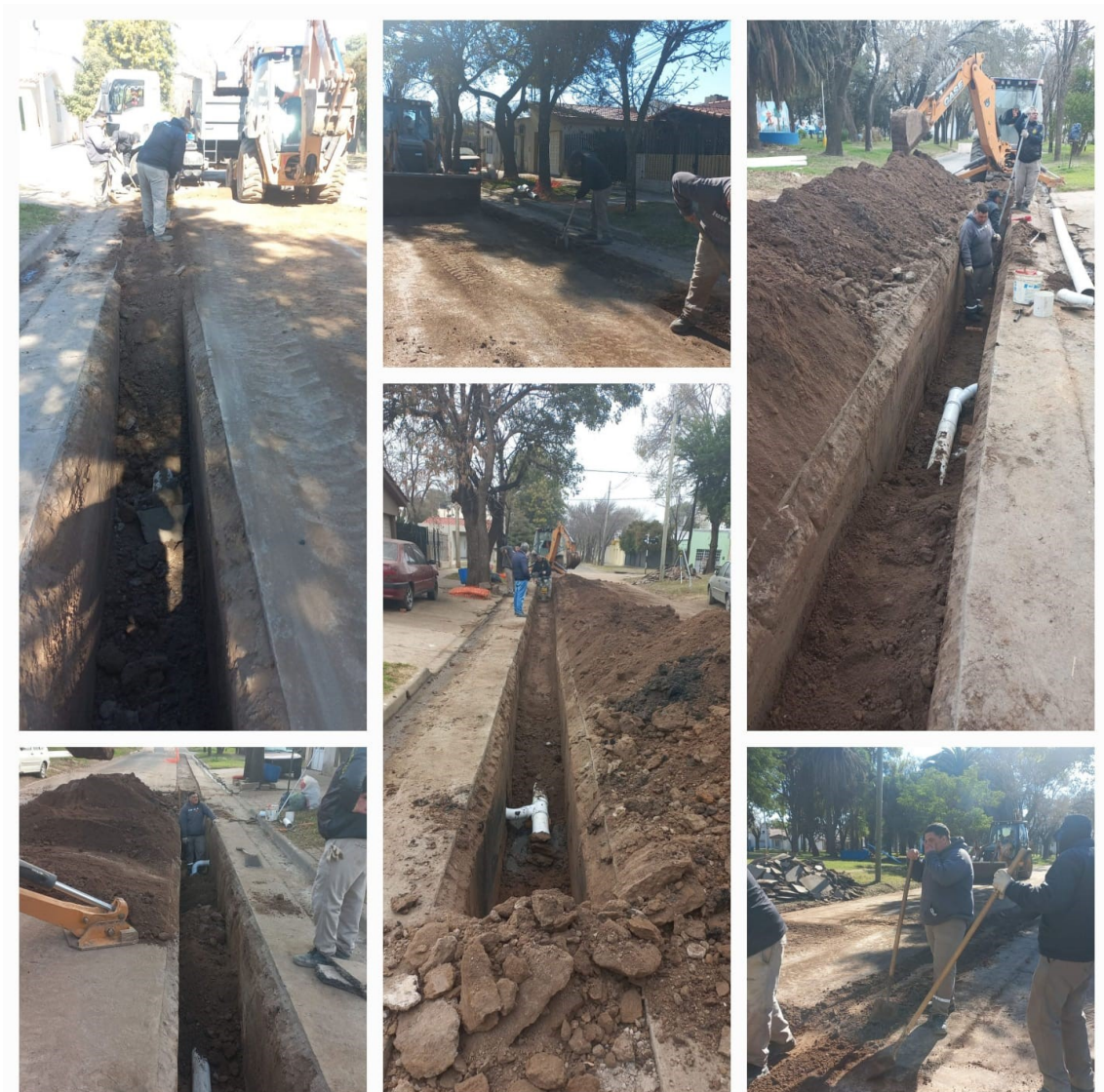
Figuras 31, 32, 33, 34, 35 y 36- Recambio cañerías en calle Ameghino 1200 a 1299
