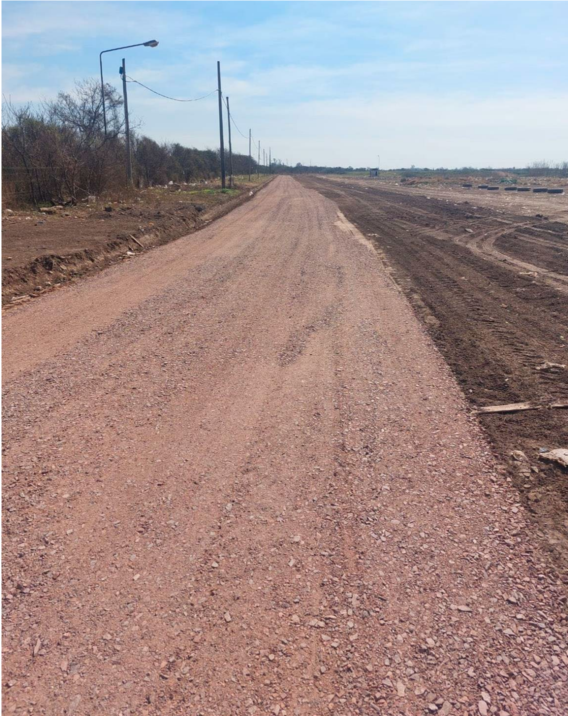
Figura 2 – Mantenimiento de caminos internos
