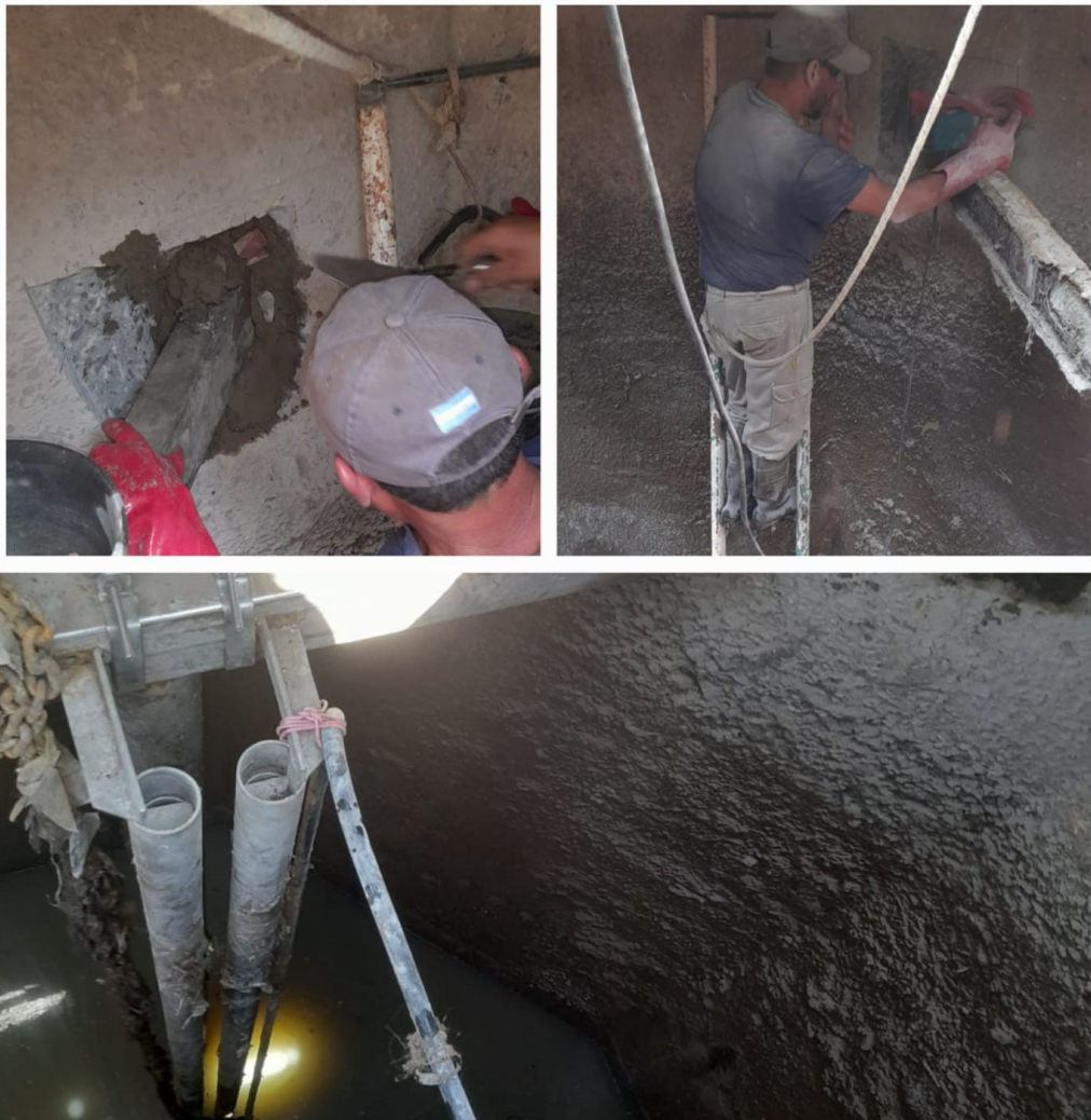
Figuras 59, 60 y 61 – Reparación de guías
