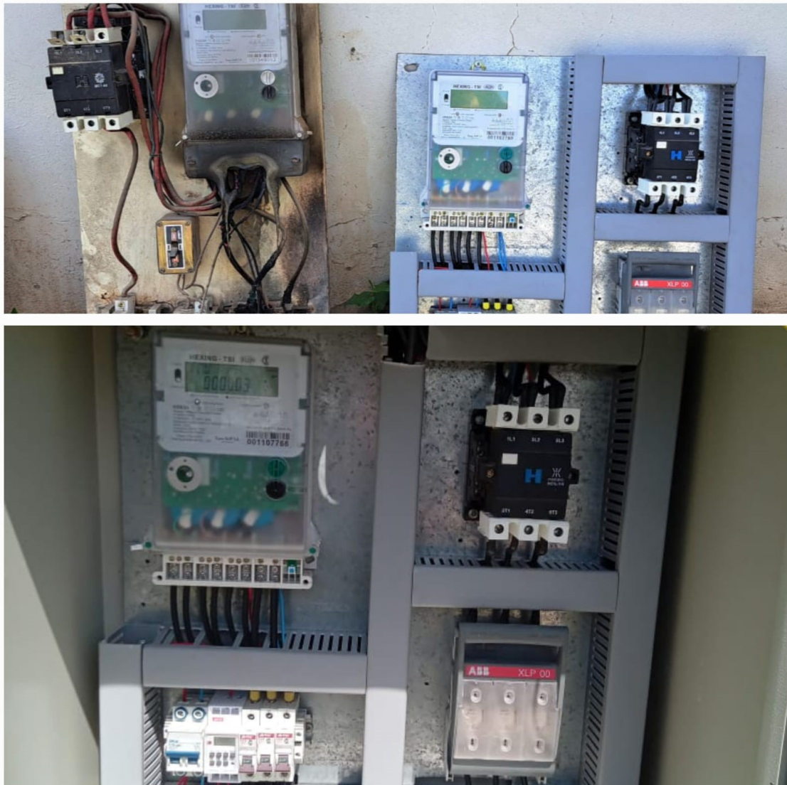
Figuras 128 Y 129 – Tablero calle Esperanza
