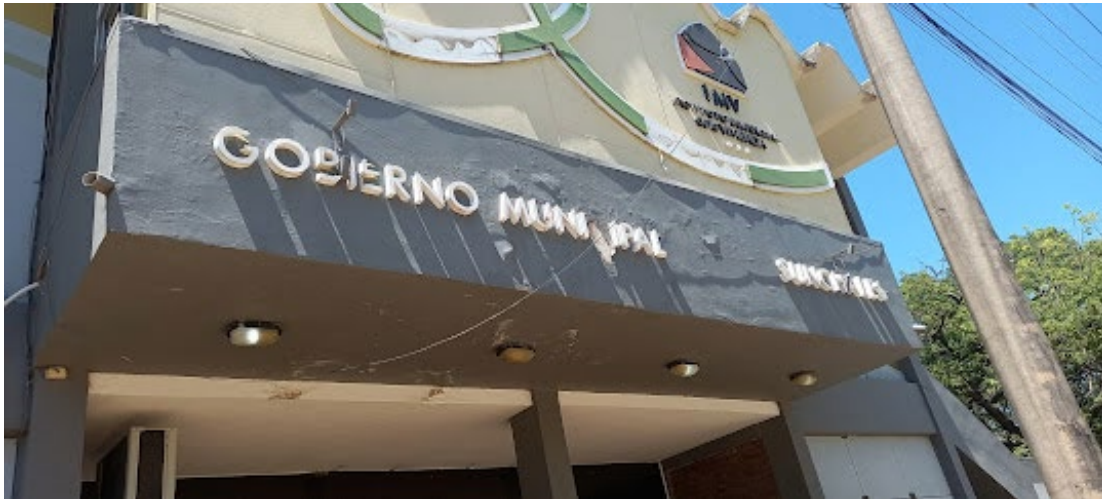
Figura 148 – Fachada previa a pintar
