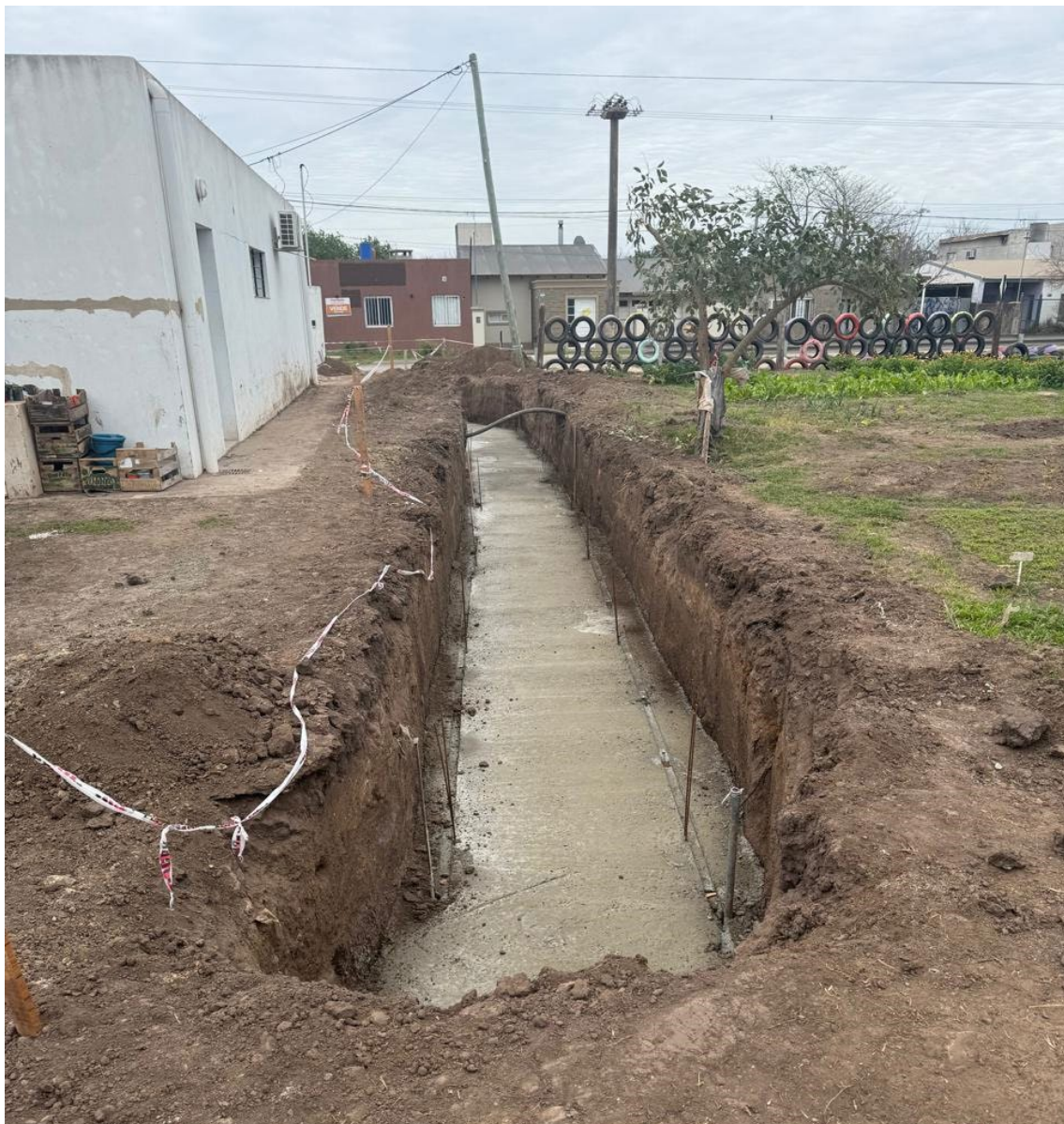
Figura 165 – Nueva Acequia en calle Guemes – Predio parque de los encuentros
