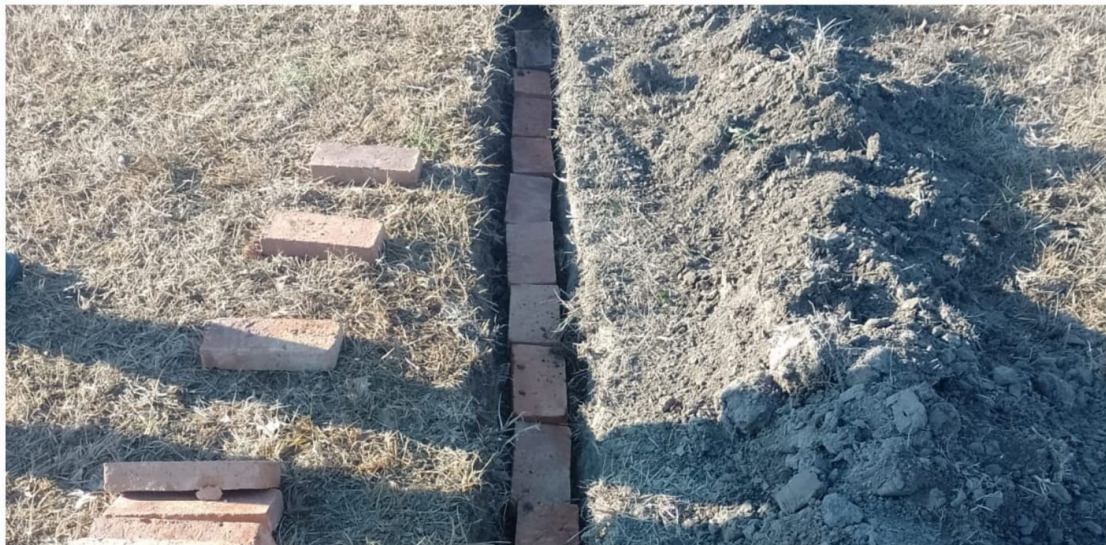
Figuras 113, 114 y 115 – Cableado subterráneo
