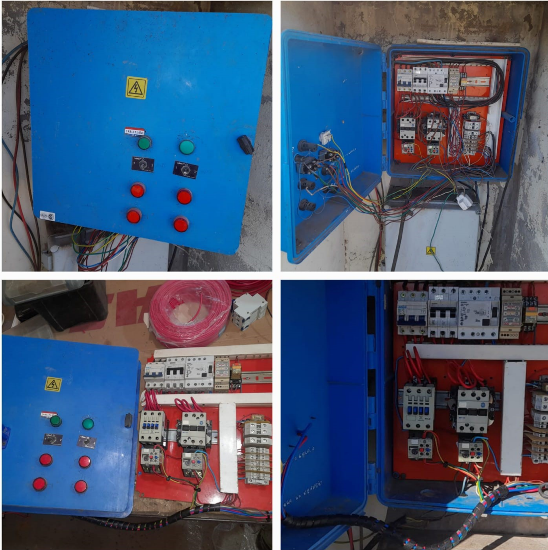
Figuras 89, 90, 91 y 92 - Tablero
