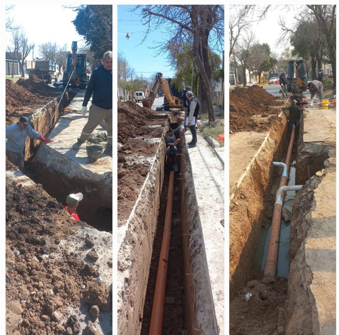
Figuras 40, 41 y 42 - Recambio cañerías en calle Rivadavia
