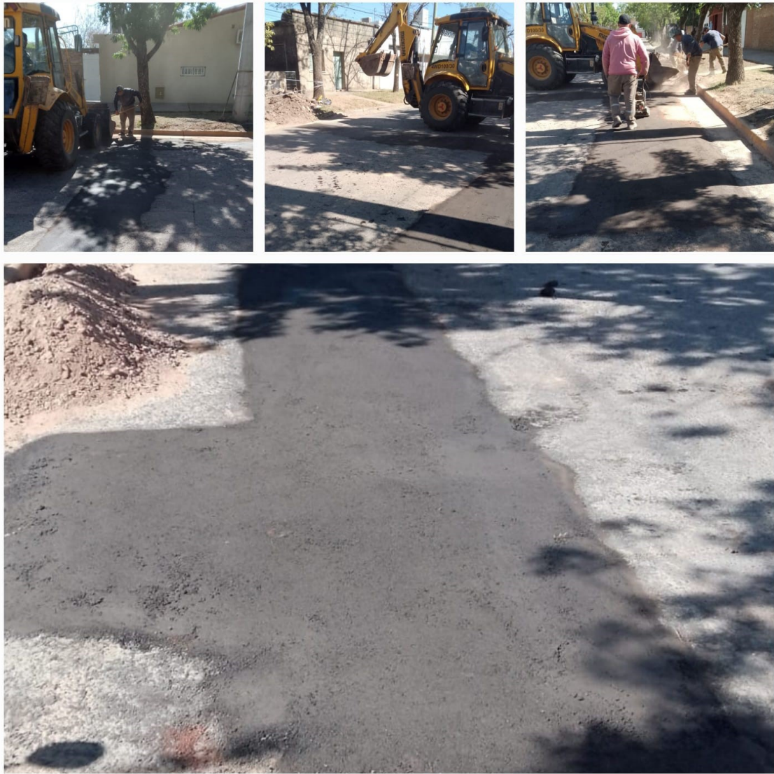
Figuras 43, 44, 45 y 46 – Cobertura asfáltica en calle Rivadavia
