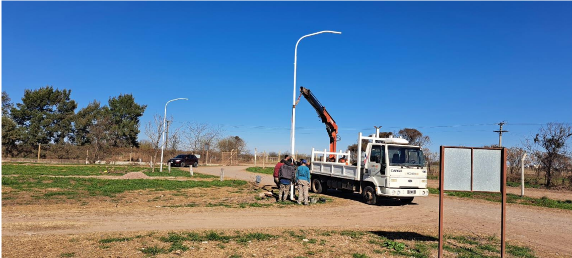
Figura 5 – Incorporación de columnas de alumbrado
